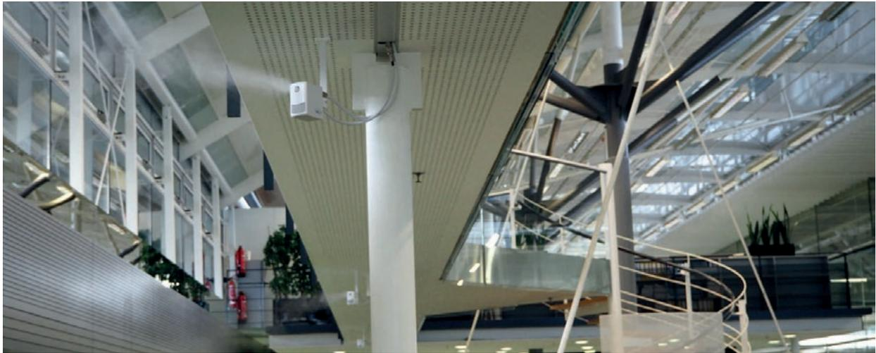
Abbildung 30: Individuelle Positionierung der Luftbefeuchter im Flurbereich bei der seele GmbH
